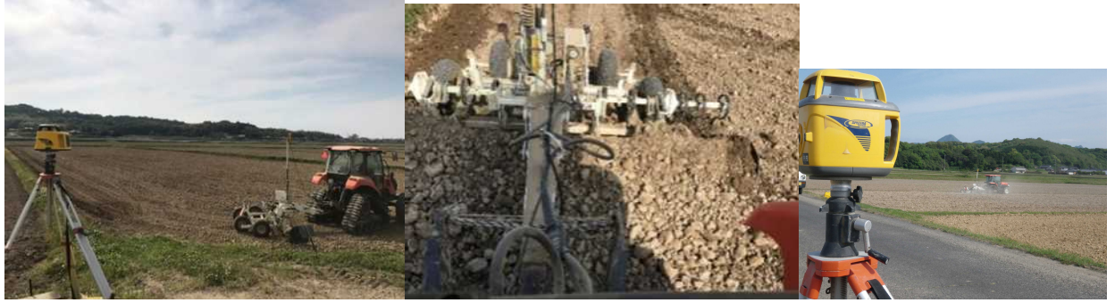
左・中央：レーザーレベラーによる整地 右：レーザー発光機
